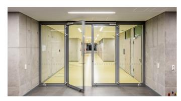
Für die Planung der Türen im Bereich der inneren Erschliessung steht der bauliche Brandschutz im Vordergrund. Diese Türanlagen sorgen auf beiden Geschossen für eine sichere Trennung zwischen Neu- und Altbau sowie zwischen Foyer und den Klassenzimmertrakten. Sie fungieren vor allem als Feuerschutzabschlüsse und werden im täglichen Gebrauch offengehalten. Ausgerüstet sind sie mit dem Gleitschienen-Türschliessersystem TS 93 von ormakaba.
